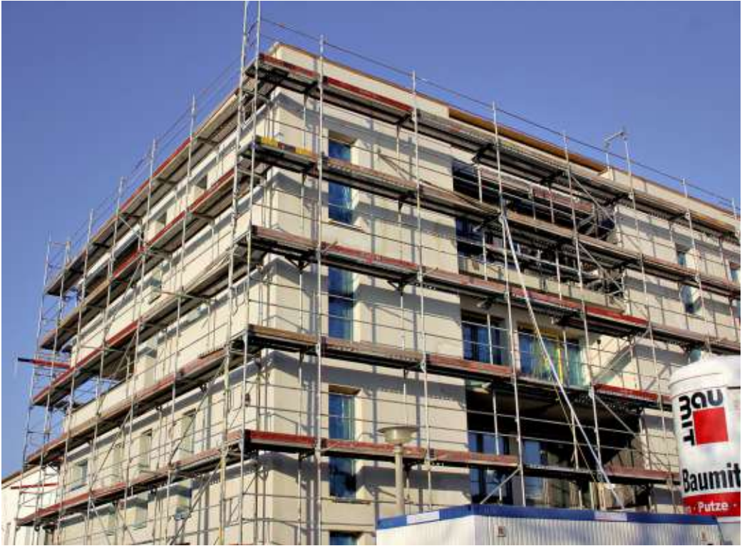
Noch ist der vierstöckige Rohbau eingerüstet. Trotz niedriger Temperaturen schreitet der Innenausbau voran. Fotos (2): Kerstin Eschke
